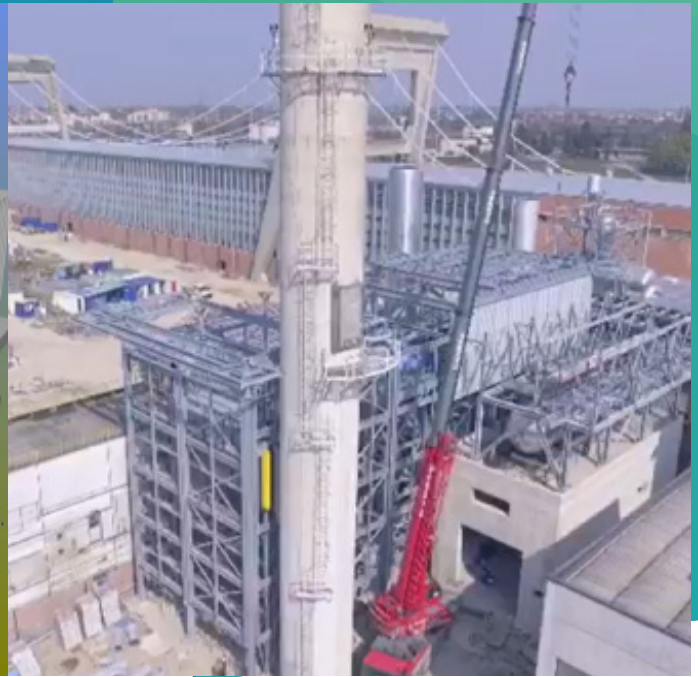
Gesamtansicht der neuen KWK-Anlage in CADWorx Plant Professional versus Baustelle am Betriebsstandort.
